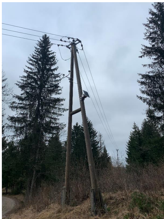
SLIKA 6: SENZOR [21] SA SOLARNIM NAPAJANJEM NA DV KALCE 20KV, AD39
